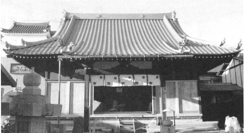
大改修中の本堂「瑠璃光殿」は、大屋根の修繕工事を終えて仮設の足場も取れ、本堂内陣、外陣、壁（耐震化）の改修作業に移っています。
